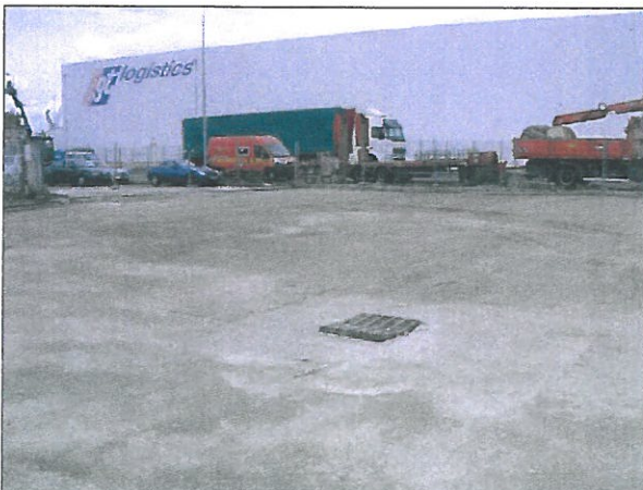
Compactage et nivellement des zones terrassées
