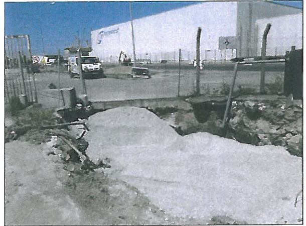
Remblaiement de la fouille avec du béton concassé
