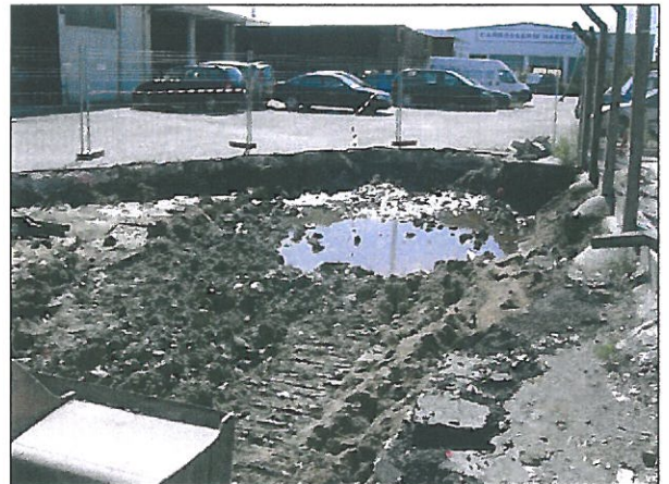
Terrassement entre la carrosserie et la piste de distribution
