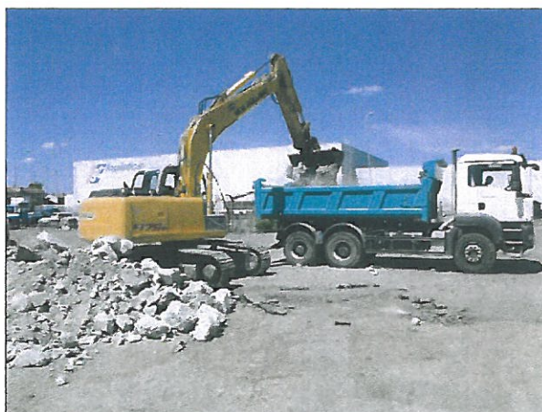
Chargement et évacuation des bétons
