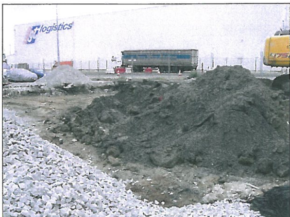
Terrassement au droit de la piste et stockage des matériaux impactés dans la fouille
