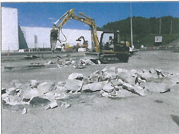
Démolition des îlots de la piste de distribution
