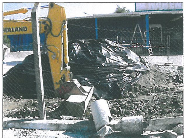
Stockage des matériaux dans la fouille, sous bâche
