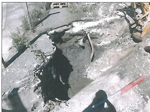
Mise en évidence de matériaux impactés en fond de fouille
