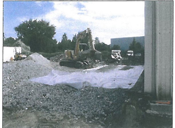
Remblaiement de la fouille et mise en place d'un géotextile
