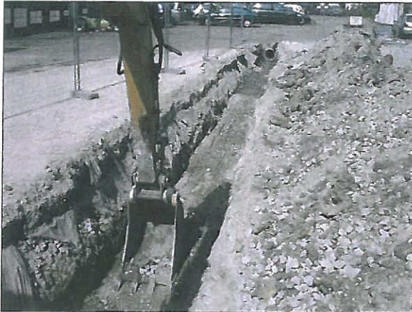
Création d'une tranchée pour la mise en place de la canalisation d'eaux pluviales
