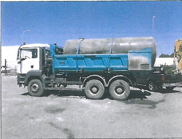
Évacuation du réservoir enterré DE/PT GO de 15 m 3
