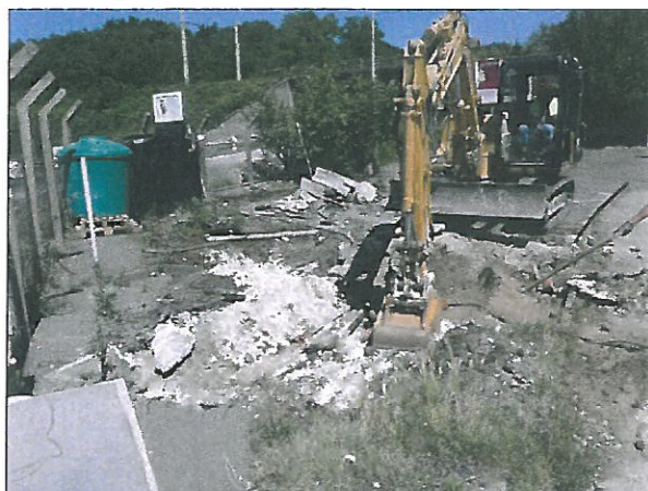
Début du terrassement au droit du réservoir enterré DE/PT GO de 15 m 3
