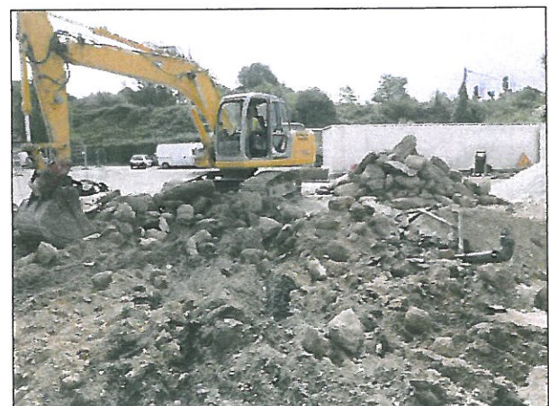
Terrassement au sud des anciens réservoirs aériens de 40 m 3 et mise en évidence, sous une couche d'enrobé, de grave ciment
