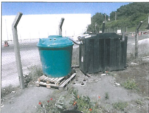
Mise en place du séparateur à hydrocarbures et de la cuve de stabilisation par INOVADIA
