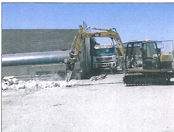
Démolition de la dalle béton de dépotage des deux réservoirs aériens de 40 m 3
