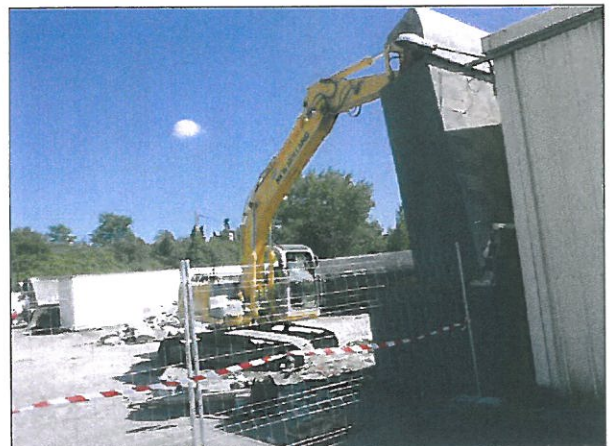
Démolition de la rétention bétonnée des deux réservoirs aériens de 40 m 3
