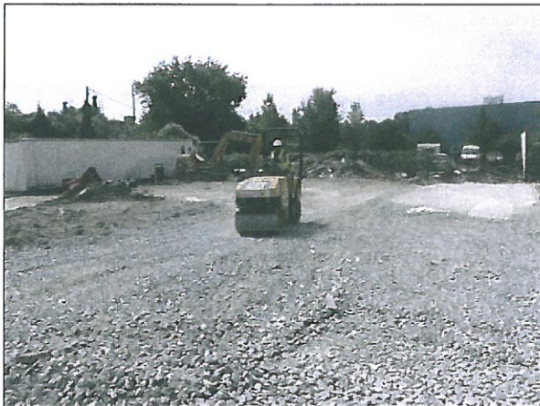
Compactage des zones remblayées
