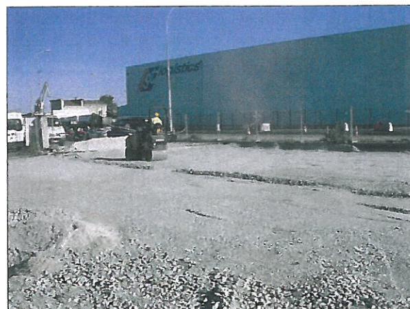
Compactage au droit de l'ancienne piste de distribution
