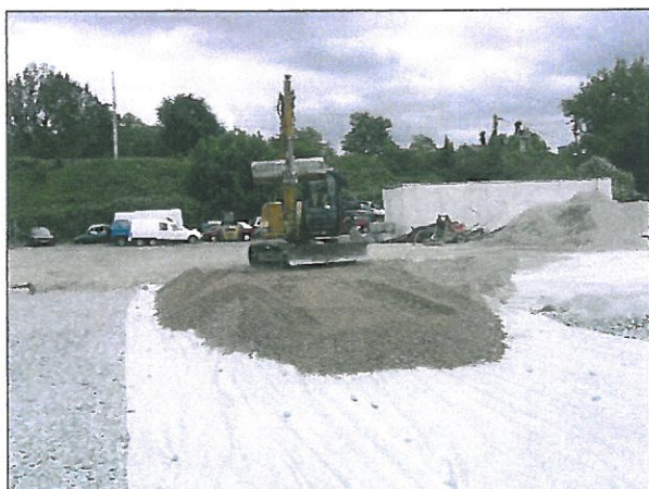
Mise en place géotextile et poursuite du remblaiement et du compactage
