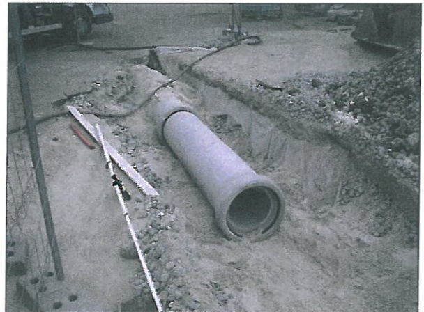
Mise en place de la canalisation d'eaux pluviales
