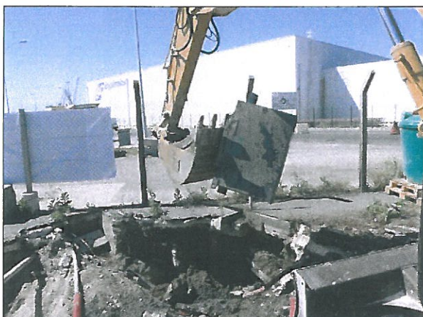
Extraction du séparateur à hydrocarbures
