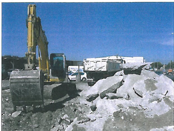
Démolition et évacuation des bétons de la piste de distribution
